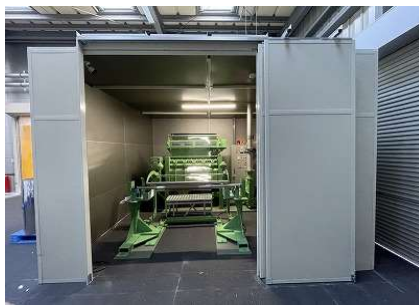
写真1 設置後_扉OPEN
